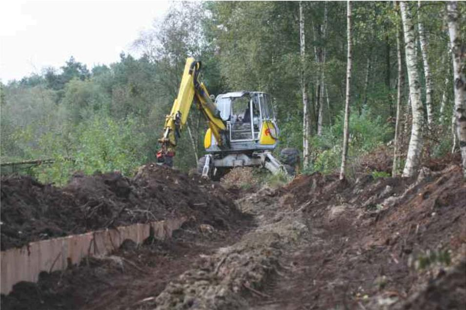
Abb. 14: Einbau einer Spundwand und Lehmshürze mit Schreitbagger, Foto K. Wittjen 2016-09-09.
